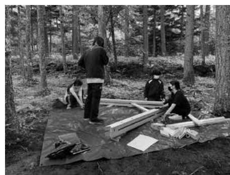
図13 トラスの地組作業の様子
