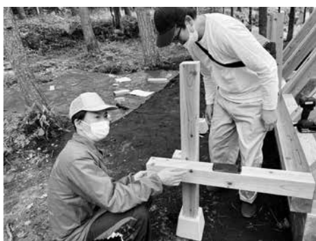
図9 デッキの施工の様子 水準器のスマホアプリで水平を計測しながら施工している。
