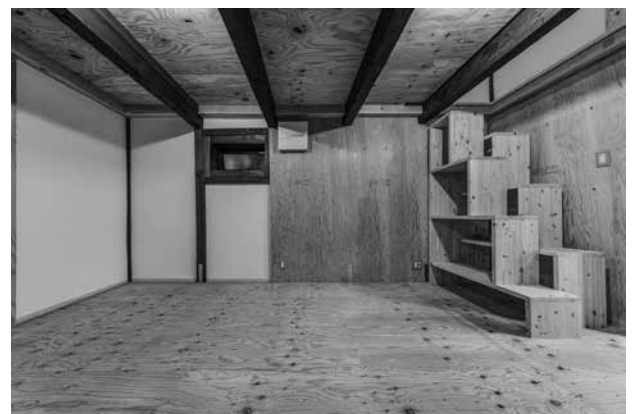
図24 黒の斜蔵（改修後） （床は水平に新設しているが、柱は傾いたまま）
