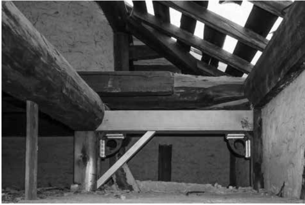
図21 昭和館（改修工事） （屋根裏に設置した耐震リング）
