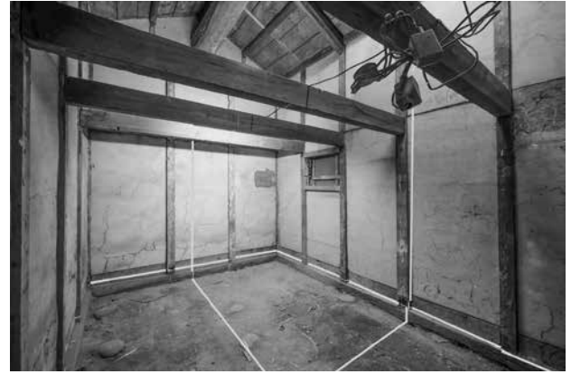
図22 黒の斜蔵（改修前） （土台と柱が一方に傾いている）
