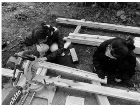
図17 木材のカットの様子 2人で確認をしながら木材のカットを行った。
