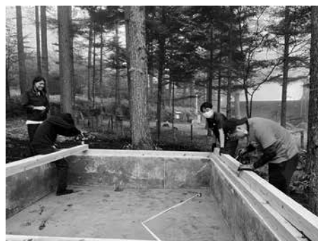
図8 2重土台施工の様子
