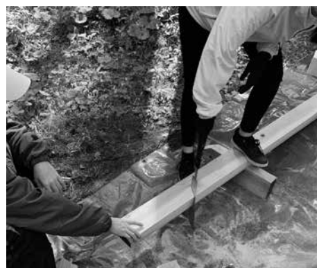
図12 トラス柱脚部のV字カット
