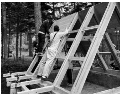
図15 野地板の留め付け
