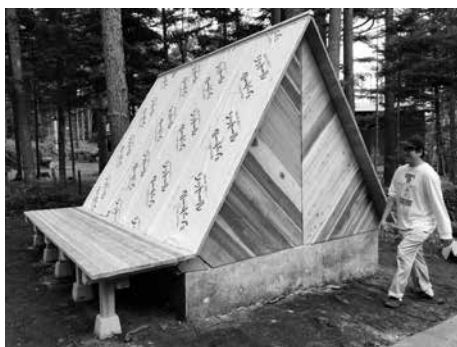
図18 防水工事後のサウナ小屋の様子
