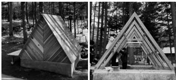
図1 実作したサウナ小屋と軸組
