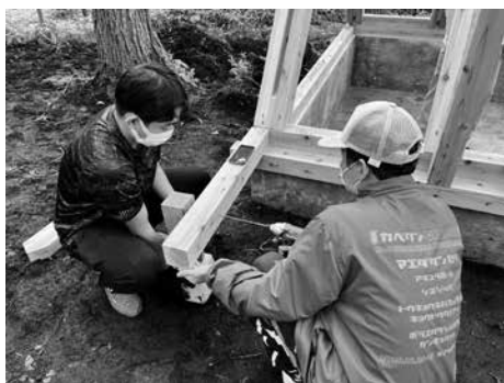
図10 デッキ受け梁と束のビス接合の様子
