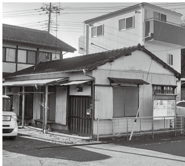
図1 戸田市の空き家事例
