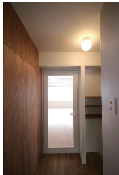
図15 光を透過する框扉：601号室
