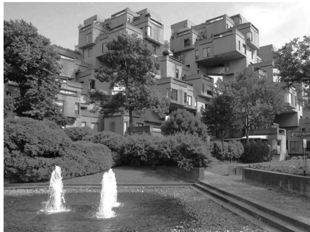
建築家 Moshe Safdie 氏によってマギル大学の修士論文をもとにモントリオール万国博覧会の一環として設計された、Habitat '67（アビタ67団地）です。モジュールユニットを積み重ねた構造になっています。写真は同会議に参加された法政大学の安藤直美氏によるものです。
