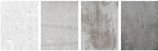
図14 コンクリート打放し経年変化画像
